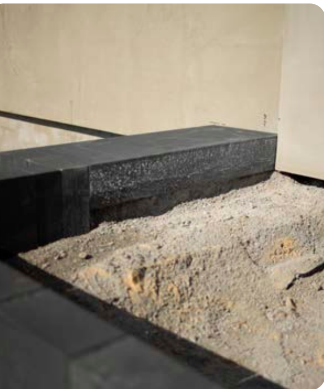
Krok 3. Osadź brzozy schodów za pomocą obrzeży lub palisad.
