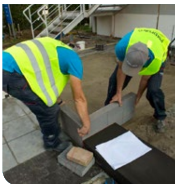
4 Rozpocznij układanie modułów
